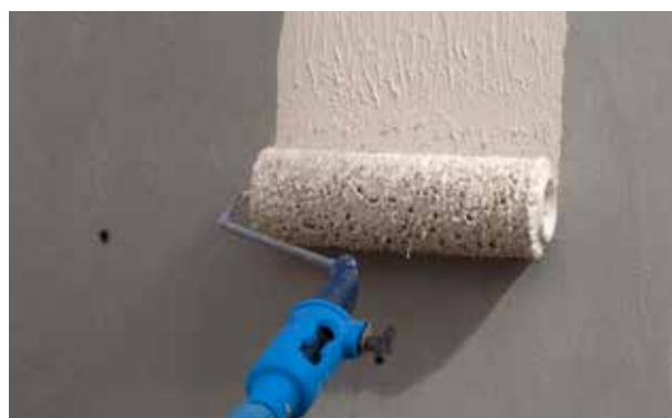
Aplicação no CX-28 Isolxtrem Poliestirex
