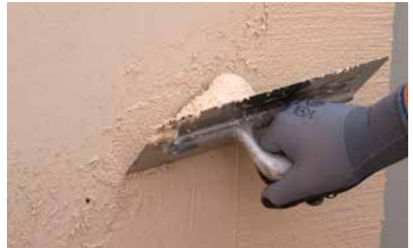
4. Appliquer le produit sur le support
