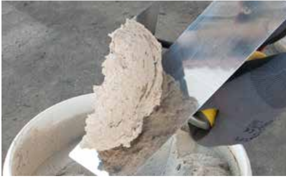
3. Déposer et répartir le produit sur une taloche ou une lisseuse
