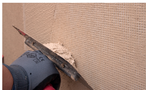
8. Cubrir la malla con PX-28 Isolxtrem SILOXANE TECHNOLOGY L.
