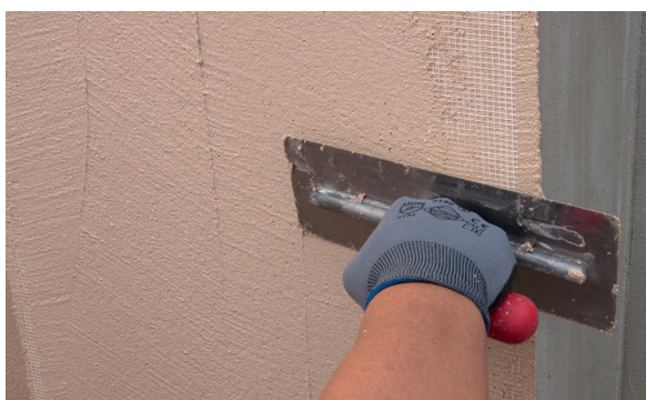
9. Alisar el PX-28 Isolxtrem SILOXANE TECHNOLOGY L depositado sobre la malla.
