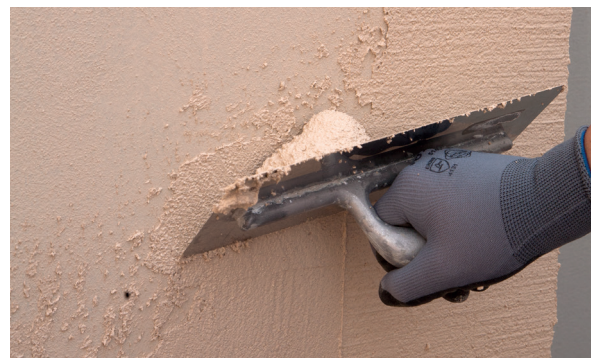
4. Aplicar PX-28 Isolxtrem SILOXANE TECHNOLOGY L sobre el soporte.
