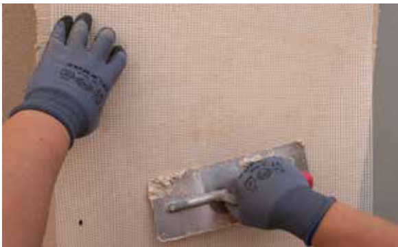
7. Positionner et insérer la maille de verre RG-116
