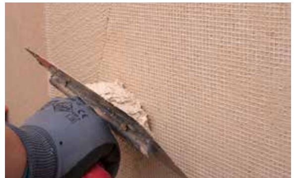
8. Recouvrir la maille de verre en totalité en appliquant une seconde couche de produit
