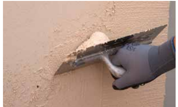
4. Appliquer le produit sur le support
