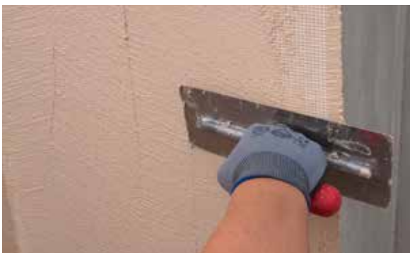
9. Lisser le produit jusqu'au recouvrement complet de la maille de verre
