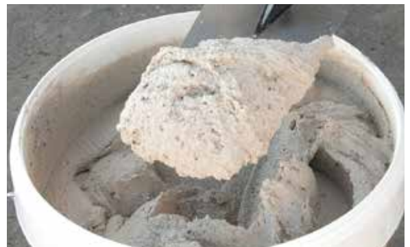
2. Extrair o PX-28 Isolxtrem SILOXANE TECNOLOGY F com a ajuda de uma pá.
