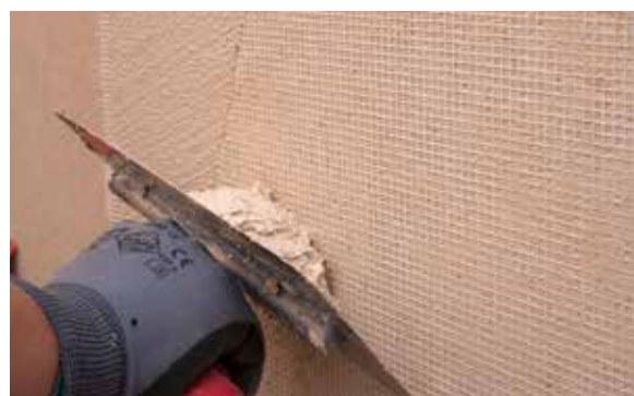
8. Cubra a malha com PX-28 Isolxtrem SILOXANE TECHNOLOGY F.
