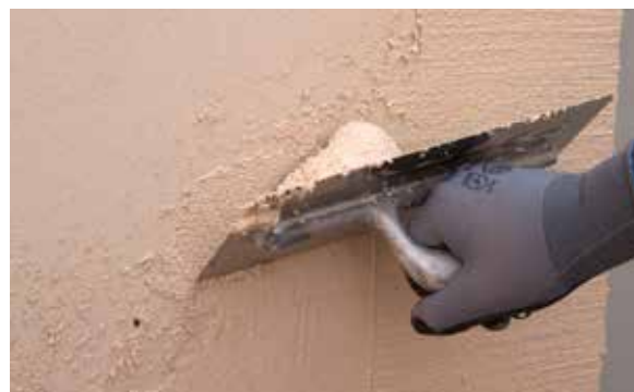
4. Aplique PX-28 Isolxtrem SILOXANE TECHNOLOGY F no suporte.
