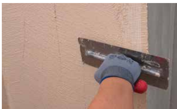
9. Alisar o PX-28 Isolxtrem SILOXANE TECHNOLOGY F depositado na malha.
