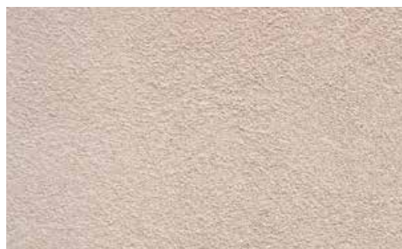
10. Acabamento final do PX-28 Isolxtrem SILOXANE TECHNOLOGY F.
