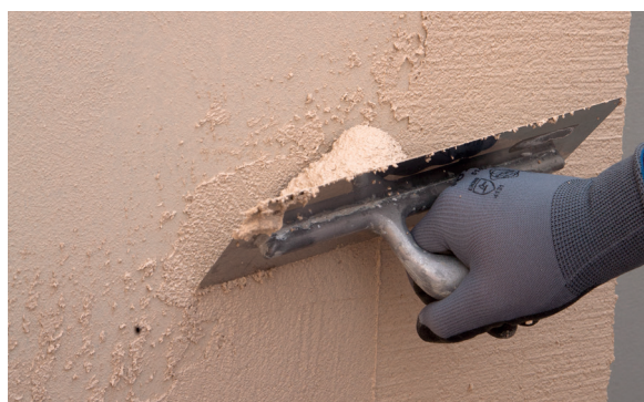
4. Aplicar PX-28 Isolxtrem SILOXANE TECHNOLOGY F sobre el soporte.
