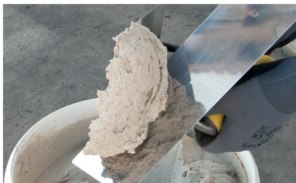
3. Colocar PX-28 Isolxtrem SILOXANE TECHNOLOGY F en la llana.
