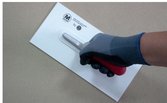
6. Fratar el PX-28 Isolxtrem SILOXANE TECHNOLOGY F.
