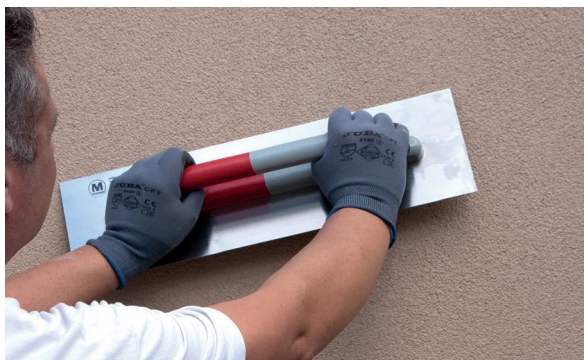
5. Alisar el PX-28 Isolxtrem SILOXANE TECHNOLOGY F.
