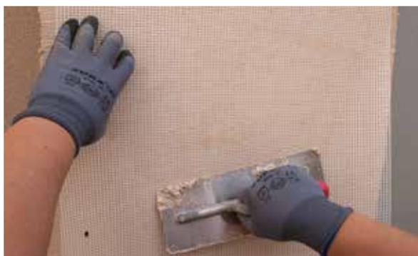
7. Colocar a malha RG-116 Isolxtrem System.
