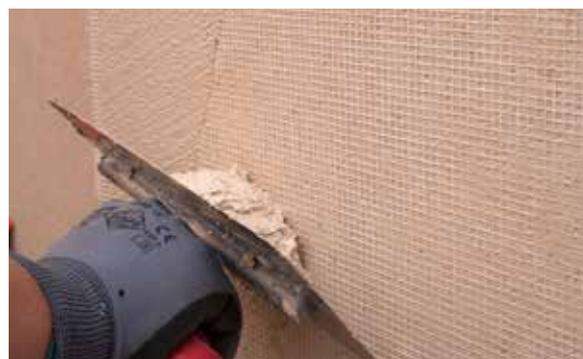
8. Cobrir a malha com PX-20 Isolxtrem RTX M.
