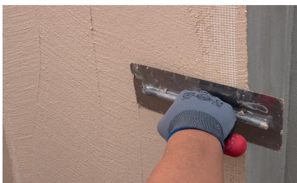
9. Alisar el PX-20 Isolxtrem RTX M depositado sobre la malla.
