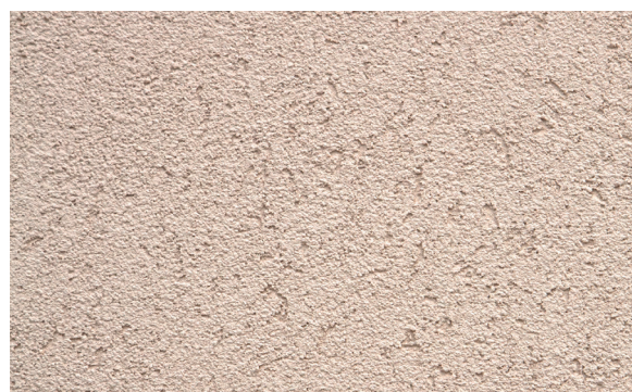
10. Acabado final del PX-20 Isolxtrem RTX M.
