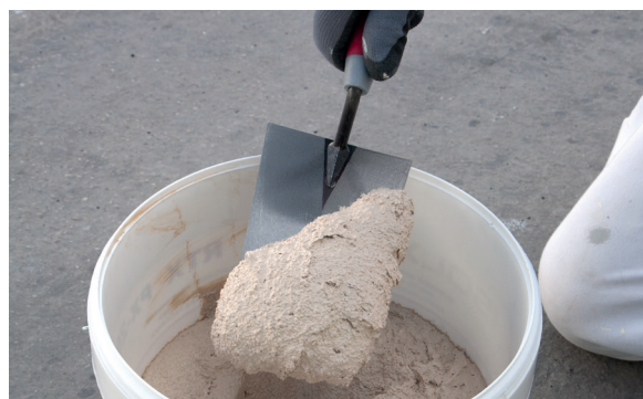
2. Extraer el PX-20 Isolxtrem RTX M con la ayuda de una paleta.
