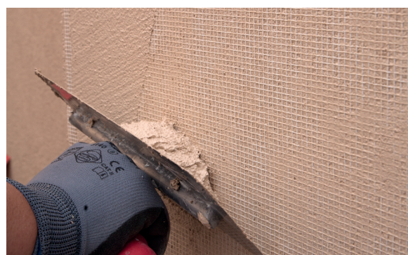
8. Cubrir la malla con PX-20 Isolxtrem RTX M.
