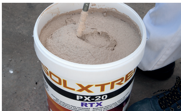
1. Remover el PX-20 Isolxtrem RTX M antes de su empleo.
