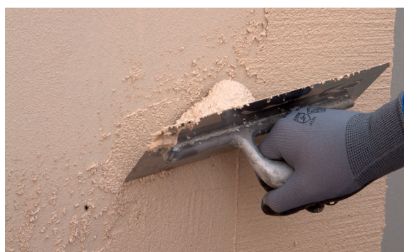
4. Aplicar PX-20 Isolxtrem RTX M sobre el soporte.
