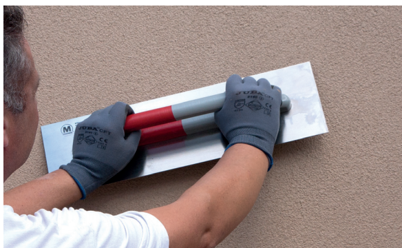
5. Alisar el PX-20 Isolxtrem RTX M.
