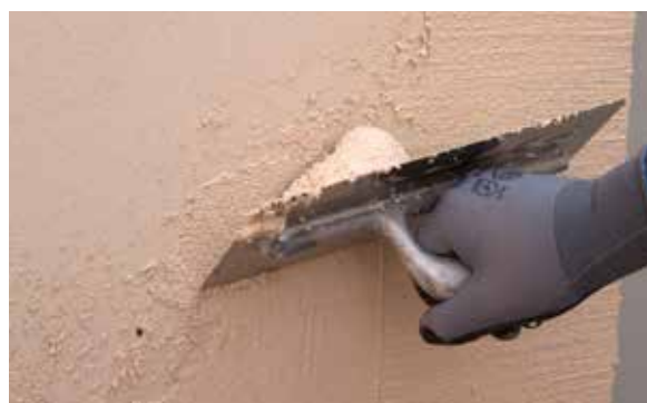
4. Aplique o PX-20 Isolxtrem RTX L no suporte.
