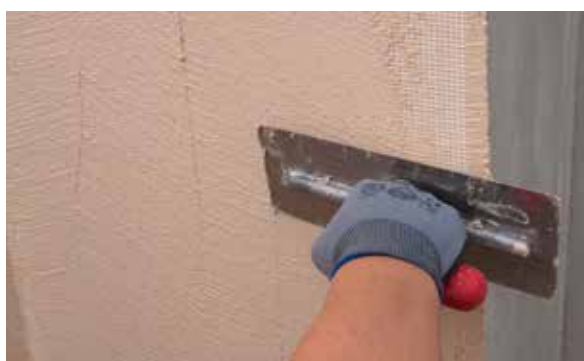
9. Alisar o PX-20 Isolxtrem RTX L depositado na malha.
