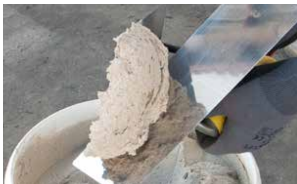
3. Colocar o PX-20 Isolxtrem RTX L na talocha.
