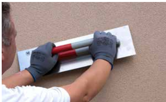
5. Alisar o PX-20 Isolxtrem RTX L.
