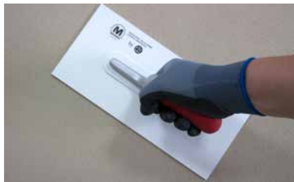
6. Espatular o PX-20 Isolxtrem RTX L.
