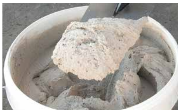
2. Extraia o PX-20 Isolxtrem RTX L com a ajuda de uma paleta.
