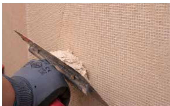
8. Cobrir a malha com PX-20 Isolxtrem RTX L.
