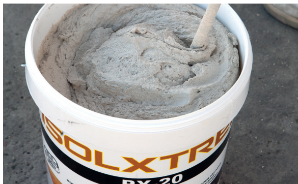
1. Remover el PX-20 Isolxtrem RTX L antes de su empleo.
