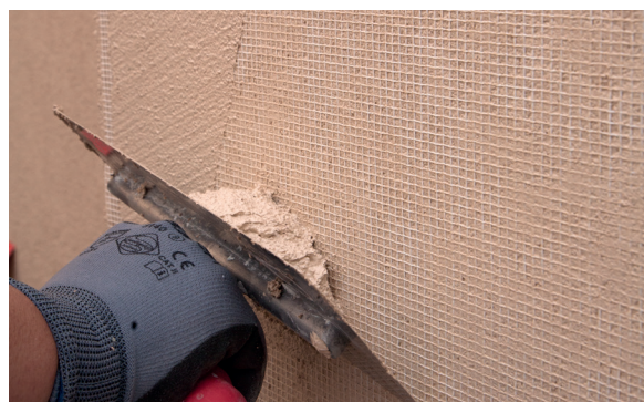
8. Cubrir la malla con PX-20 Isolxtrem RTX L.
