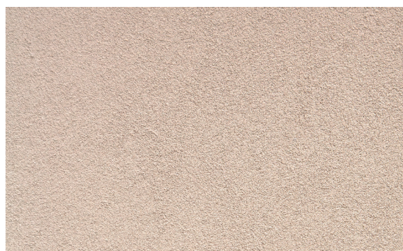
10. Acabado final del PX-20 Isolxtrem RTX L.
