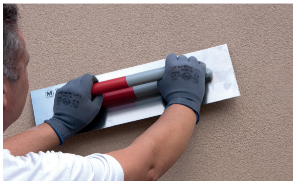
5. Alisar el PX-20 Isolxtrem RTX L.
