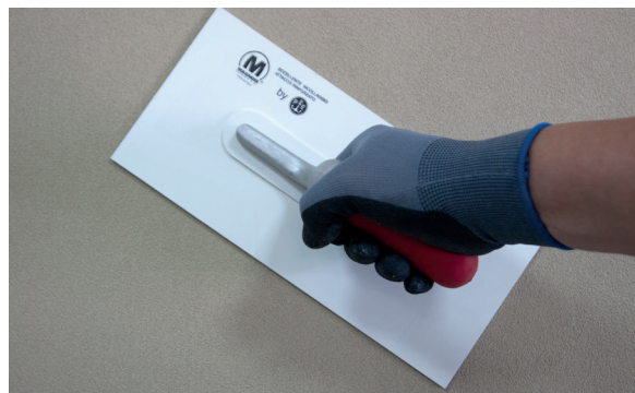
6. Fratar el PX-20 Isolxtrem RTX L.
