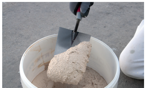
2. Utiliser une taloche pour extraire l'enduit
