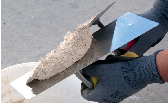
3. Déposer sur une taloche grand format.
