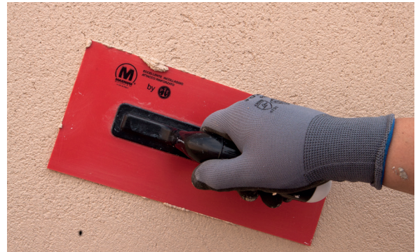
6. Frotter avec une gréseuse.
