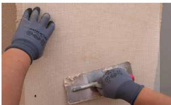
7. Colocar a malha RG-116 Isolxtrem System.
