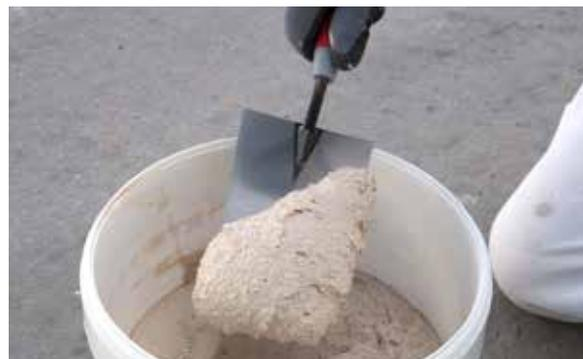
2. Extraia o PX-20 Isolxtrem RTX G com a ajuda de uma paleta.
