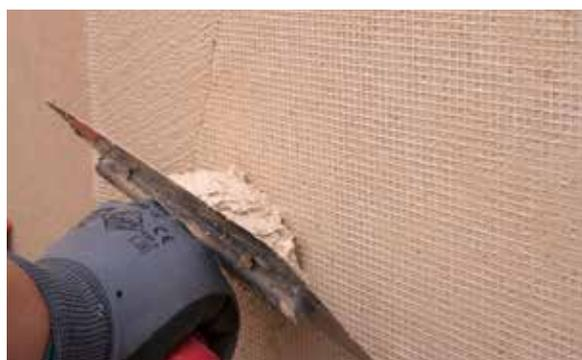
8. Cobrir a malha com PX-20 Isolxtrem RTX G.
