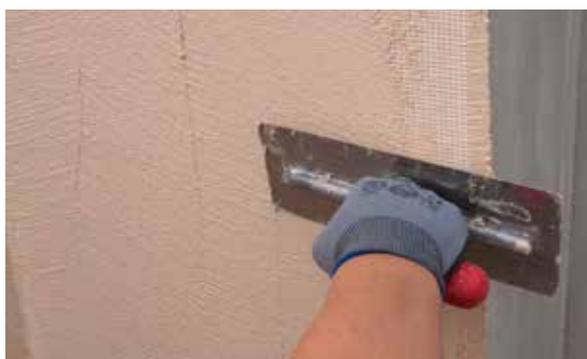
9. Alisar o PX-20 Isolxtrem RTX G depositado na malha.
