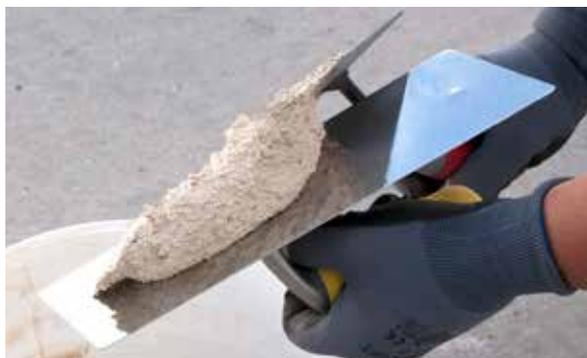
3. Colocar o PX-20 Isolxtrem RTX G na talocha.
