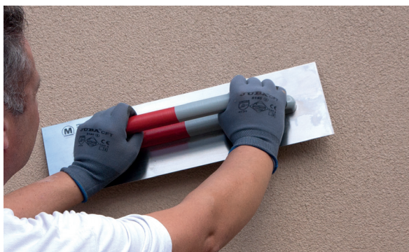
5. Alisar el PX-20 Isolxtrem RTX G.
