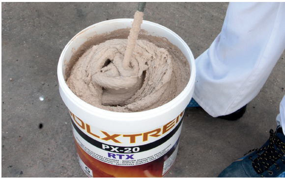
1. Remover el PX-20 Isolxtrem RTX G antes de su empleo.
