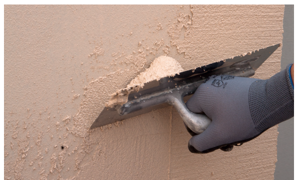
4. Aplicar PX-20 Isolxtrem RTX G sobre el soporte.
