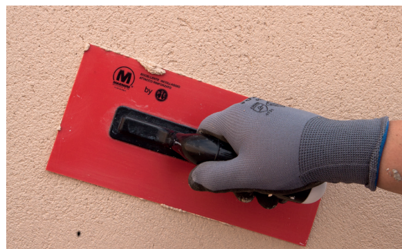
6. Fratar el PX-20 Isolxtrem RTX G.
