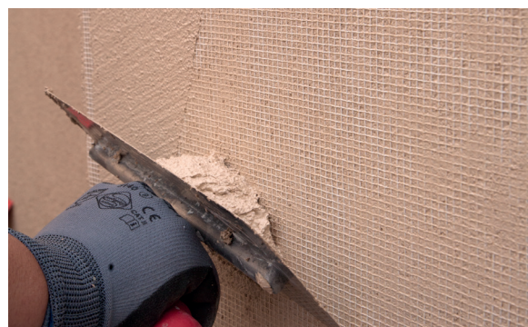
8. Cubrir la malla con PX-20 Isolxtrem RTX G.
