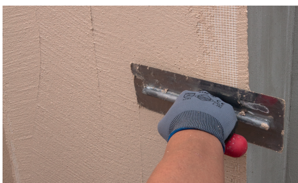
9. Alisar el PX-20 Isolxtrem RTX G depositado sobre la malla.
