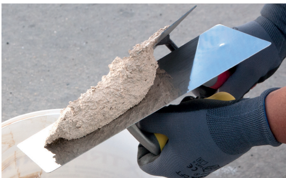
3. Colocar PX-20 Isolxtrem RTX G en la llana.
