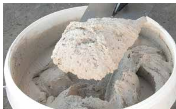
2. Extraia o PX-20 Isolxtrem RTX F com a ajuda de uma paleta.
