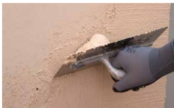
4. Aplique o PX-20 Isolxtrem RTX F no suporte.
