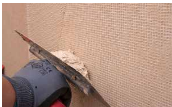
8. Cobrir a malha com PX-20 Isolxtrem RTX F.
