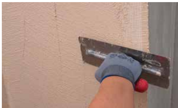
9. Alisar o PX-20 Isolxtrem RTX F depositado na malha.
