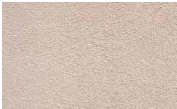
10. Acabamento final do PX-20 Isolxtrem RTX F.
