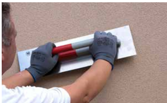
5. Alisar o PX-20 Isolxtrem RTX F.
