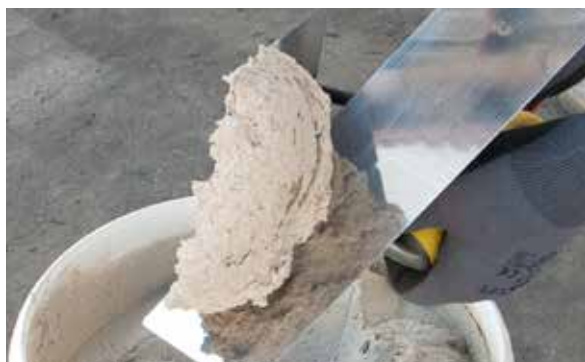
3. Colocar o PX-20 Isolxtrem RTX F na talocha.
