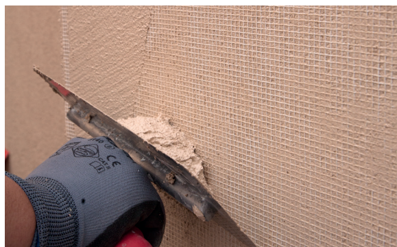
8. Cubrir la malla con PX-20 Isolxtrem RTX F.
