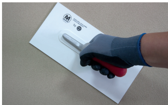
6. Fratar el PX-20 Isolxtrem RTX F.
