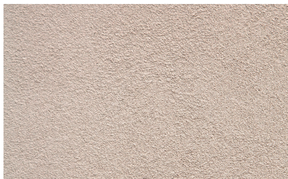
10. Acabado final del PX-20 Isolxtrem RTX F.
