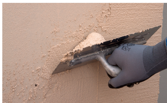
4. Aplicar PX-20 Isolxtrem RTX F sobre el soporte.
