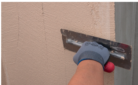
9. Alisar el PX-20 Isolxtrem RTX F depositado sobre la malla.
