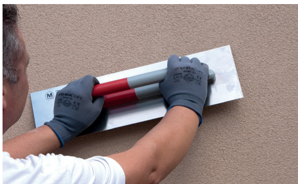
5. Alisar el PX-20 Isolxtrem RTX F.
