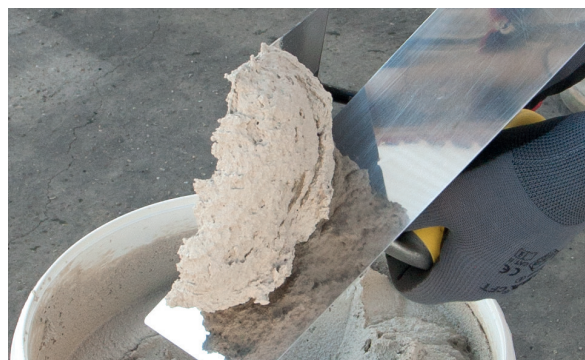
3. Colocar PX-20 Isolxtrem RTX F en la llana.
