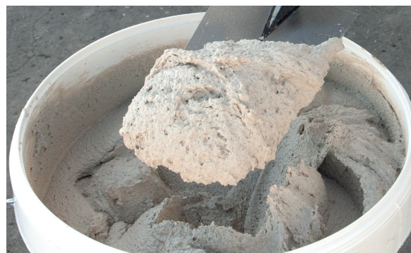
2. Extraer el PX-20 Isolxtrem RTX F con la ayuda de una paleta.
