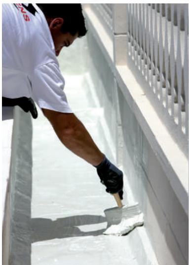
Appliquer une seconde couche de façon croisée en déposant abondamment le produit. Une bonne imperméabilisation requiert une épaisseur de 2 à 3mm obtenue lors des couches successives.
