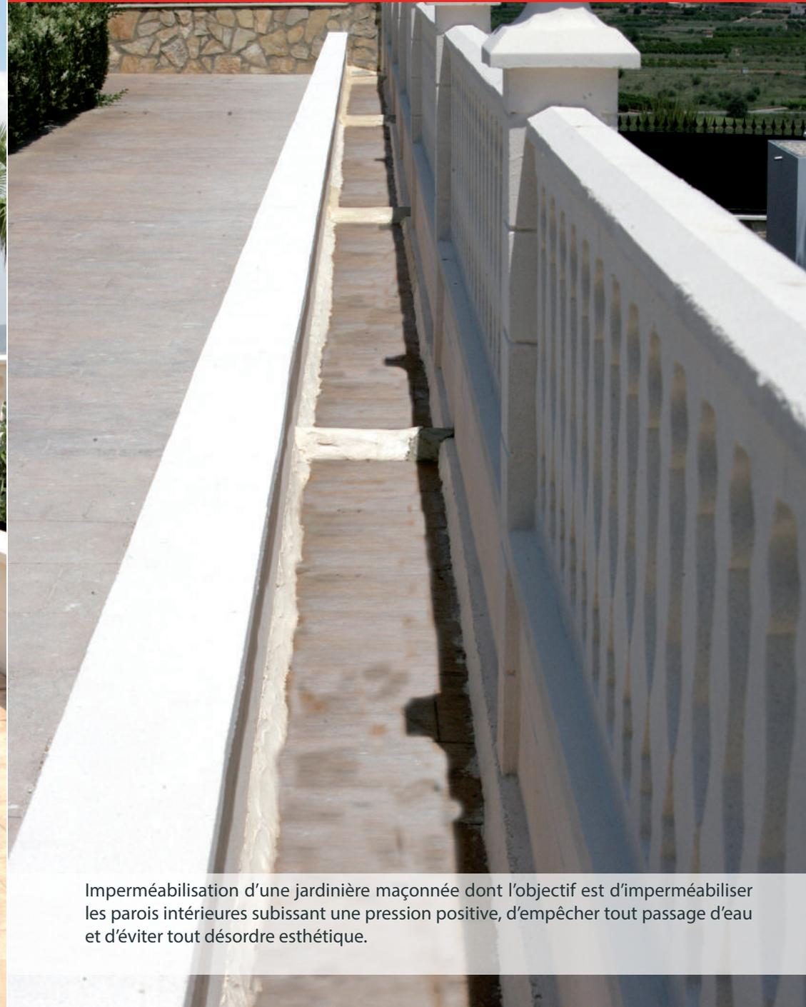
Imperméabilisation d'une jardinière maçonnée dont l'objectif est d'imperméabiliser les parois intérieures subissant une pression positive, d'empêcher tout passage d'eau et d'éviter tout désordre esthétique.
