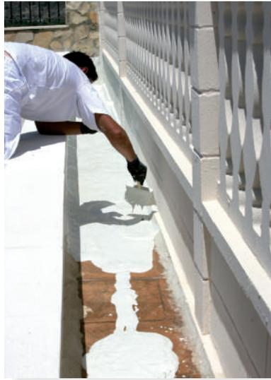
Appliquer de préférence avec un spalter ou une brosse à fibres synthétiques, en répartissant lors de la 1ère couche le produit de manière uniforme sur toute la surface à imperméabiliser, en veillant à ne laisser aucune porosité.
