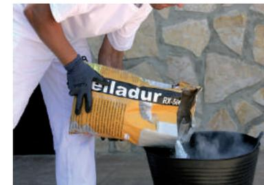
Mélanger le produit, de préférence avec un mélangeur électrique afin d'obtenir une pâte parfaitement homogène et sans grumeaux. Laisser reposer quelques minutes, puis appliquer.
