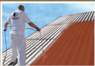
Impermeabilización directa sobre una vieja cubierta de fibrocemento o cemento amianto.
