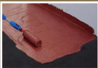
Impermeabilización directa sobre viejas impermeabilizaciones (fondos bituminosos, láminas asfálticas, membranas acrílicas)
