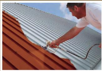
Impermeabilización directa sobre metales (hierro, zinc, plancha galvanizada, etc.)
