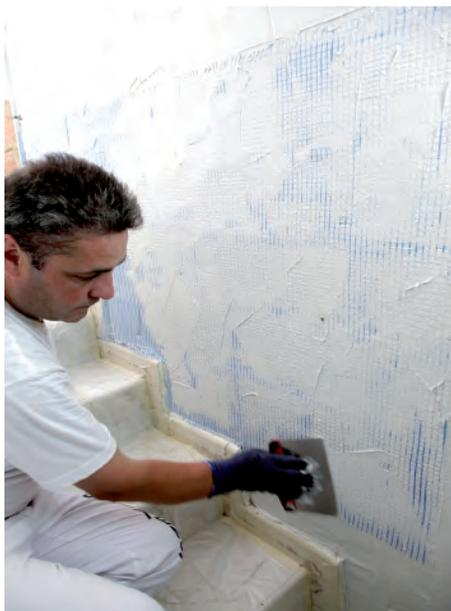
Una vez aplicada la primera mano de material y, sin dejarla fraguar, depositaremos la malla de fibra de vidrio RG-102 Malla especial mortero/revoco, presionándola ligeramente con la ayuda de una espátula o con la misma llana, haciendo que penetre en la primera capa de RX-512 Selladur Rellenos, para a continuación, fresco sobre fresco, aplicar otra capa de producto que la cubra totalmente.
