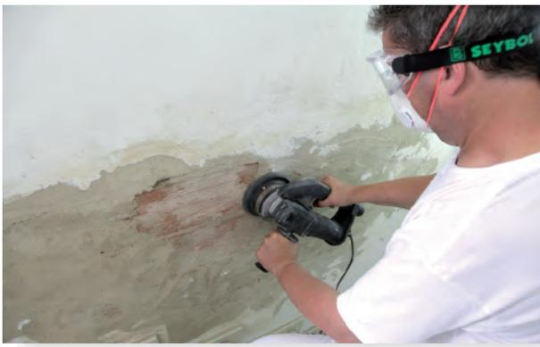
Con la ayuda de una máquina fresadora eliminaremos la capa de mortero salitroso, afectada por la humedad (mortero débil y pulverulento) hasta llegar al fondo fuerte, en este caso soporte de ladrillo cerámico.
