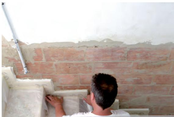
Protección de superficies, de suelos u otros elementos, previa a la aplicación del sistema de impermeabilización, con el fin de no dejar manchas irreversibles.
