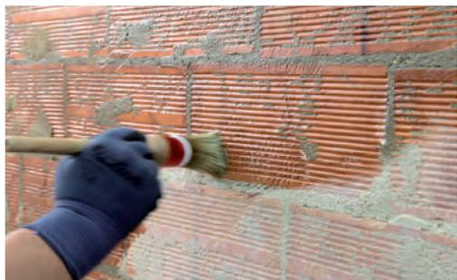
Aplicación de una capa de RX-501 Fijaprán al disolvente que sirve, en este caso, para la fijación de restos de polvo y predispone el fondo para recibir el mortero impermeabilizante.
