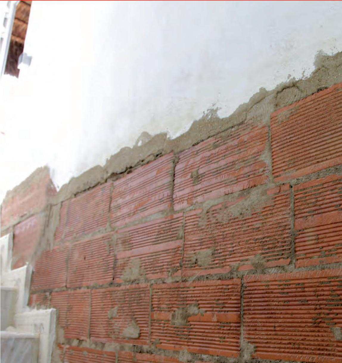
Aspecto del soporte una vez tratado con RX-501 Fijaprén al disolvente y preparado para su impermeabilización con RX-512 Selladur Rellenos
