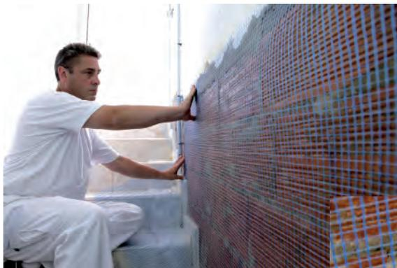
Preparación y corte a medida de la malla de fibra de vidrio RG-102 Malla especial mortero/revoco que servirá como refuerzo interior del RX-512 Sellador Rellenos.
