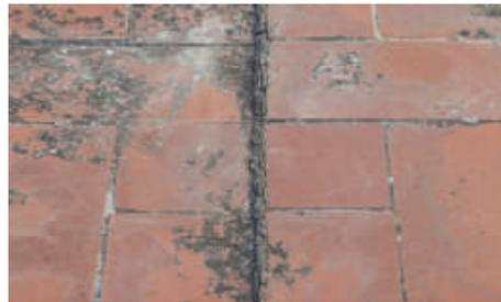
Cuando se trate de una obra de rehabilitación en la que no existan juntas de dilatación en la zona a impermeabilizar, habrá que proceder a la realización de las mismas con una radial, cuidando siempre de hacer las hendiduras dentro de las dimensiones que la norma dispone: la profundidad del corte de la radial será de 4 ó 5 cm como mínimo y el ancho de corte, el que predisponga la herramienta.
