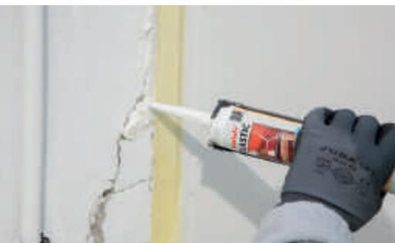
Acondicionar las confluencias de los paramentos verticales con los horizontales, saneando las fisuras y desperfectos superiores a 2 mm. Abrir las fisuras al menos dos veces su tamaño inicial y aplicar en el interior nuestro consolidador **RX-501 FIJAPREN AL DISOLVENTE**. Dejar secar al menos 4 horas y, a continuación, rellenar las grietas con nuestra masilla **RX-400 RUALAIX ELASTIC** o con nuestra **MASILLA PARA JUNTAS DE DILATACIÓN B-32C**.
