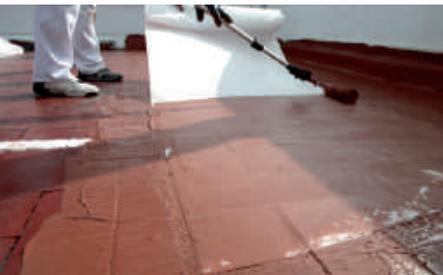
Seguidamente, y antes de que se inicie el secado de la primera capa, se aplicará una segunda mano del producto impermeabilizante, de modo que el velo de fibra quede tapado o cubierto en su totalidad.
