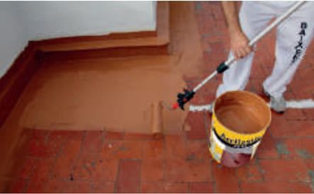
Concluida la preparación de los zócalos y otros puntos singulares, tenderemos el producto sobre una superficie cuya anchura sea algo superior al ancho de la pieza de velo de fibra de vidrio que hemos previamente recortado a medida de la anchura de la terraza a impermeabilizar.
