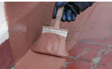
El alambor que vamos a formar se realizará impregnando abundantemente las paredes y el suelo de la zona con producto impermeabilizante.
