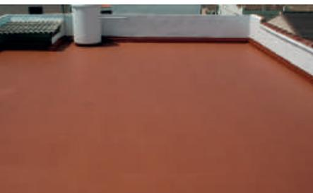
Seguiremos hasta el final de la impermeabilización con los pasos previamente mencionados, recordando que en todo el proceso la colocación de la banda de velo de fibra se realiza superponiendo una sobre otra, montando unos 3 centímetros.
