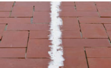
Conviene puentear las juntas de dilatación restauradas mediante una tira de velo de fibra de vidrio de unos 15 centímetros de anchura a lo largo de toda la junta, para recubrirla posteriormente con el mismo impermeabilizante que utilizaremos para hacer la impermeabilización de la terraza.
