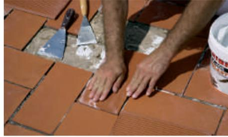
Si se trata de una obra nueva con las juntas de dilatación ya existentes, se procederá al relleno de las mismas con nuestro **RX-400 RUALAIX ELASTIC** o con nuestra masilla para juntas de dilatación **B-32C**.
