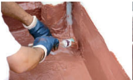
Comprobar el buen estado de los desagües y aplicar el producto impermeabilizante en el interior de los mismos, empapando abundantemente el velo de fibra de vidrio.
