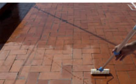
En obras de rehabilitación que requieren una restauración intensa, además de sanear las partes que presenten un aspecto harinoso y/o deleznable, se consolidará el fondo a impermeabilizar con nuestro fijador **RX-501 FIJAPREN AL DISOLVENTE**.
