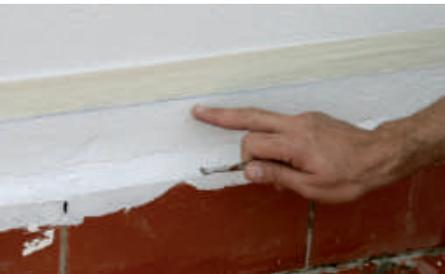
Antes de impermeabilizar la superficie horizontal de la terraza, procederemos a impermeabilizar los zócalos para que de esta manera se logre un buen hermetismo.
