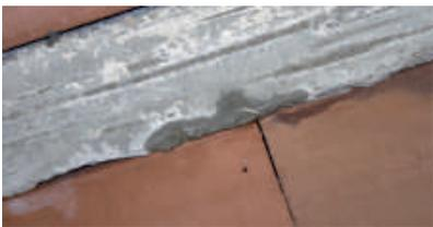
La acción constante del agua y de los cambios térmicos acaban provocando la aparición de vías de penetración del agua.
