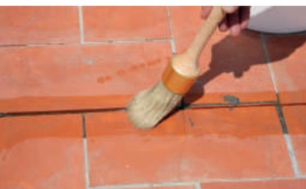
Las juntas y las fisuras entre piezas degradadas deben eliminarse tomando siempre la precaución de que el hueco quede totalmente limpio y vacío. Con el fin de endurecer y consolidar el polvo resultante, usaremos nuestro fijador consolidador **RX-501 FIJAPREN AL DISOLVENTE**.
