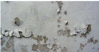
El deterioro de los componentes de la terraza y las vías de agua hacia el interior degradan progresivamente los revestimientos decorativos tales como escayola, pintura, yeso, etc.
