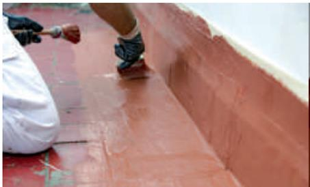
Es importante asegurarse que, durante todo el proceso de impermeabilización, la colocación de la banda de velo de fibra se realiza superponiendo una sobre otra, montando unos 3 centímetros, y cubriendo muy bien la junta con impermeabilizante.
