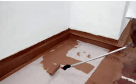
A continuación, y sobre esta superficie ya impregnada, se instalará el velo de fibra de vidrio ejerciendo presión con el rodillo para que el velo de fibra de vidrio se empape hasta saturación.
