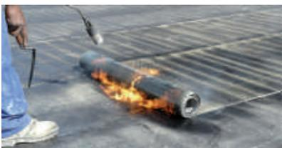
Los sistemas tradicionales de impermeabilización, como las telas asfálticas, se hacen rígidos con el tiempo y se rompen, lo que se traduce en altos costes de reparación y mantenimiento.
