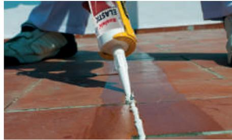
Si se trata de una obra vieja con las juntas de dilatación rellenas con otros productos elásticos, procederemos a la eliminación y vaciado de dichas juntas para, seguidamente, rellenarlas con nuestro **RX-400 RUALAIX ELASTIC** o con nuestra masilla para juntas de dilatación **B-32C**.
