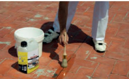
Una vez realizado el corte, se aspirará todo el polvo y se consolidará con nuestro **RX-501 FIJAPREN AL DISOLVENTE** el interior de la junta. Sólo entonces procederemos con el tratamiento de la junta como si fuera de obra nueva, rellenándola con nuestro **RX-400 RUALAIX ELASTIC** o con nuestra masilla para juntas de dilatación **B-32C**.
