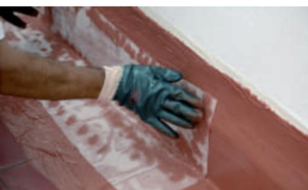
Seguidamente procederemos a colocar el velo de fibra previamente recortado a medida de manera que quede bien adherido a la pared y al suelo.
