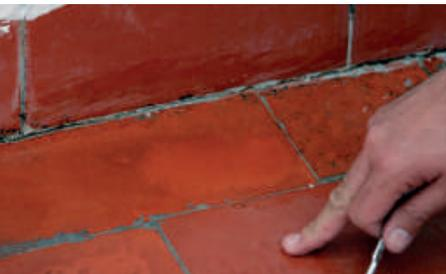
Comprobar el estado de los ángulos con las paredes para la separación de terrazas y los muros de cerramiento. Estas zonas deben revisarse siempre que se realicen labores de mantenimiento, pues suelen ser los puntos por donde se inician casi todas las filtraciones de agua.
