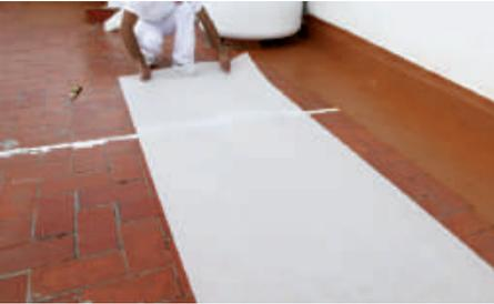
Para una aplicación más eficiente y rápida, recomendamos la preparación con antelación de los materiales que vamos a utilizar. Es particularmente importante cortar el velo de fibra de vidrio según la medida de la terraza que vayamos a impermeabilizar.
