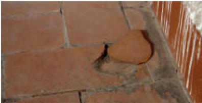
La absorción de los materiales y la nula deformabilidad de las juntas de mortero entre las piezas, provocan una lenta degradación de la terraza. La aparición de hongos y otros microorganismos contribuye también al deterioro.
