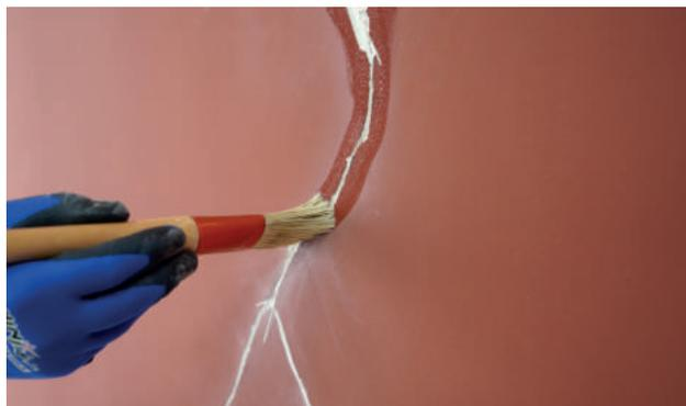
4. Appliquer l'enduit avec un couteau à reboucher en exerçant une pression vers l'intérieur de la cavité
