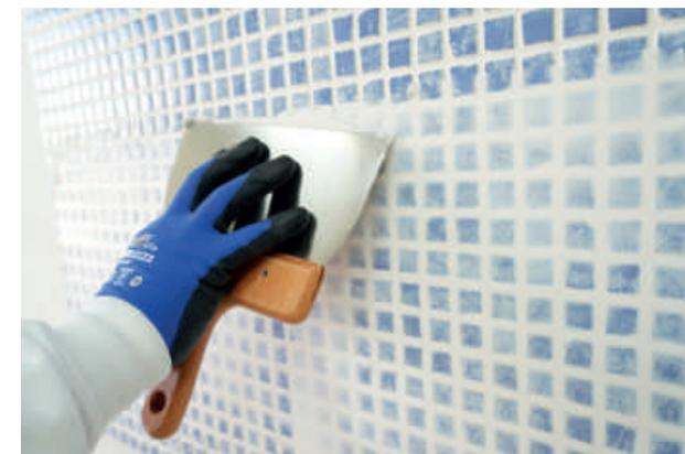
Si les joints sont creux (cas de la pâte de verre), appliquer en plein une 1ère passe d'enduit lissée afin de les recouvrir avec une lisseuse large.
