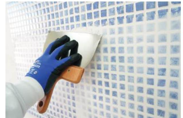
Si les joints sont creux (cas de la pâte de verre), appliquer en plein une 1<sup>ère</sup> passe d'enduit lissée afin de les recouvrir avec une lisseuse large.
