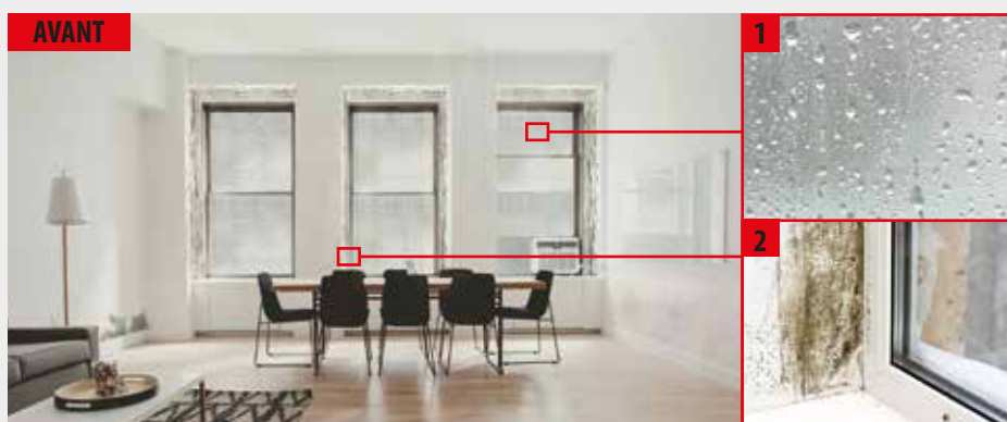
1. Gouttes d'eau produites par la condensation 2. Tâches de moisissure
