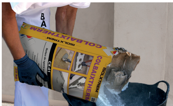
1. Ajouter la poudre CX-41 Colbaixtherm à l'eau
