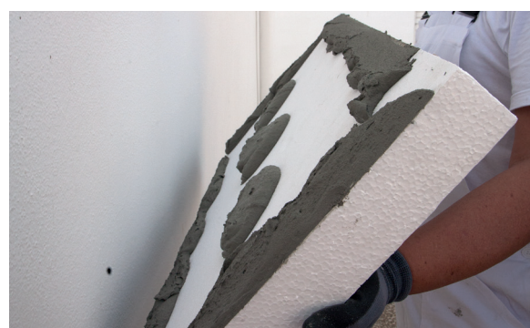
6. Positionnement de la plaque sur le support à isoler
