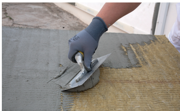
7. Enduisage du panneau en laine de roche
