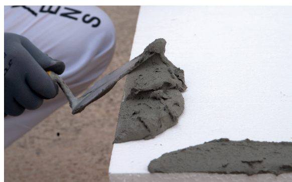
4. Application du produit sur les panneaux EPS
