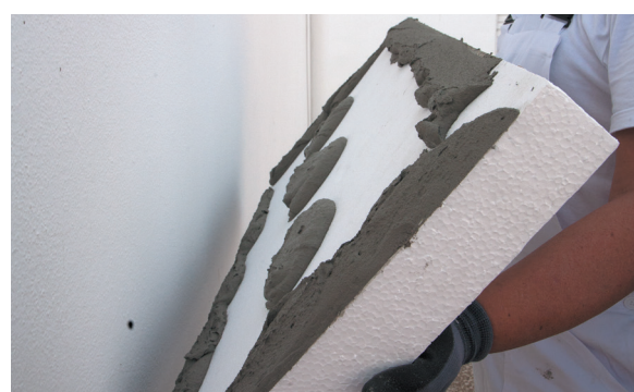
6. Colocacion de la placa sobre el soporte
