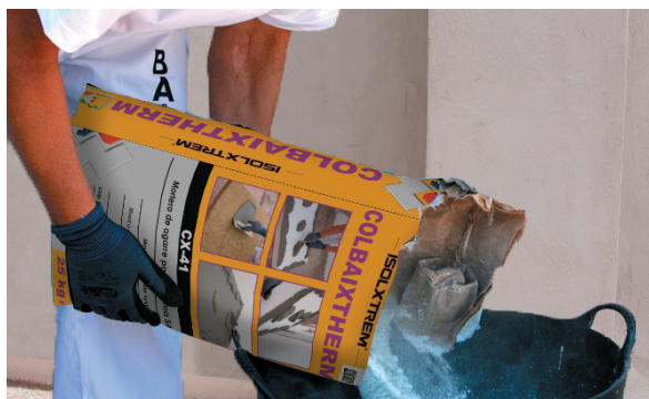
1. Adición del CX-41 Colbaixtherm al agua
