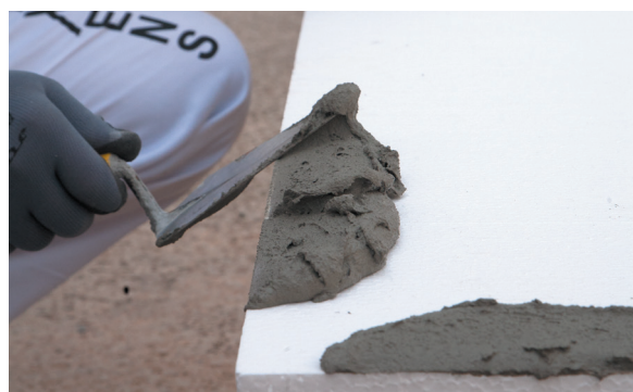
4. Aplicación del CX-41 Colbaixtherm sobre EPS
