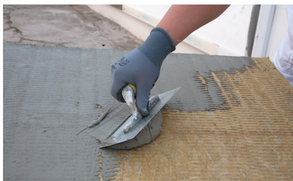
7. Enlucido de placa de lana de roca
