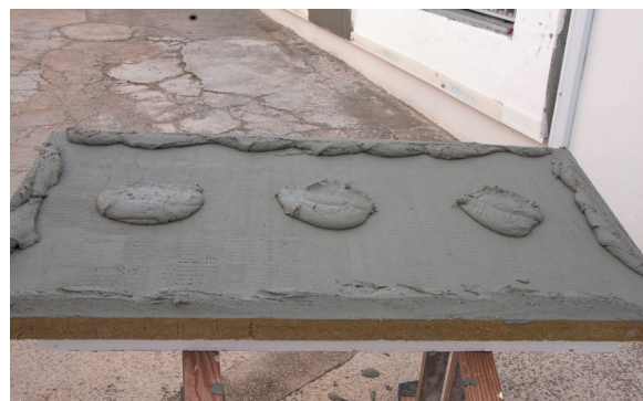
8. Encolado de placa de lana de roca
