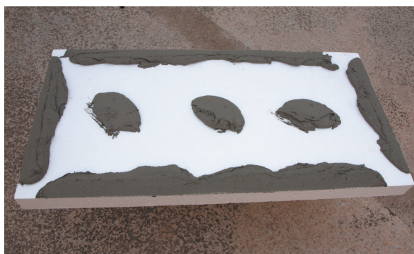
5. Encolado de placa de EPS
