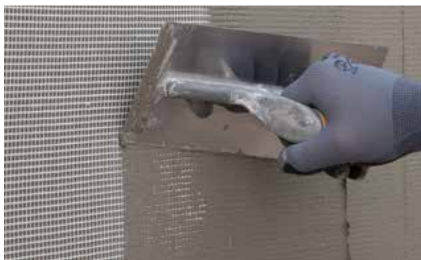
11. Colocação da malha de reforço
