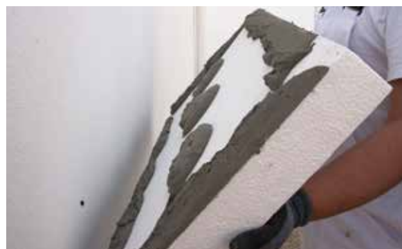
6. Colocação da placa no suporte
