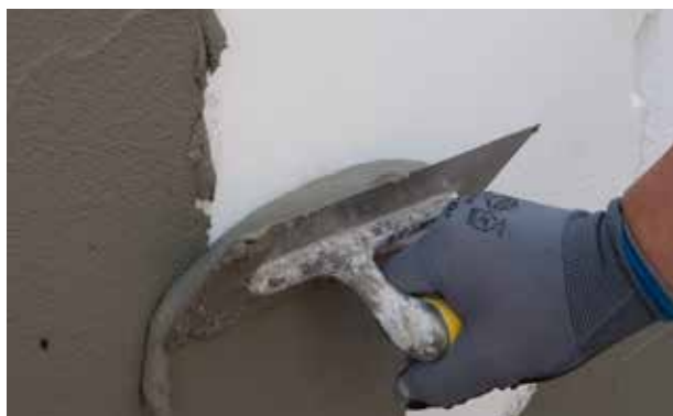
9. Reboco das placas
