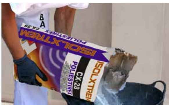
1. Adição de CX-28 Isolxtrem Poliestirex de água
