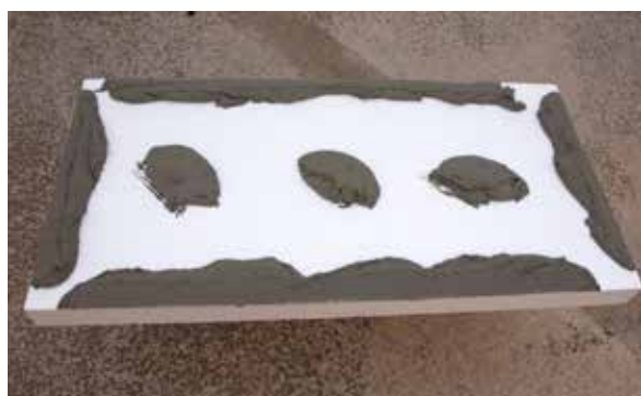
5. Colagem de painéis EPS
