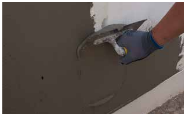
10. Reboco das placas
