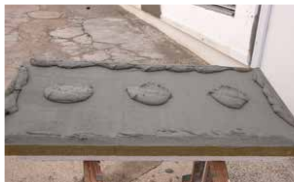
8. Colocação da placa de lâ de rocha
