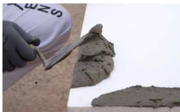
4. Aplicação do CX-28 Isolxtrem Poliestirex em EPS
