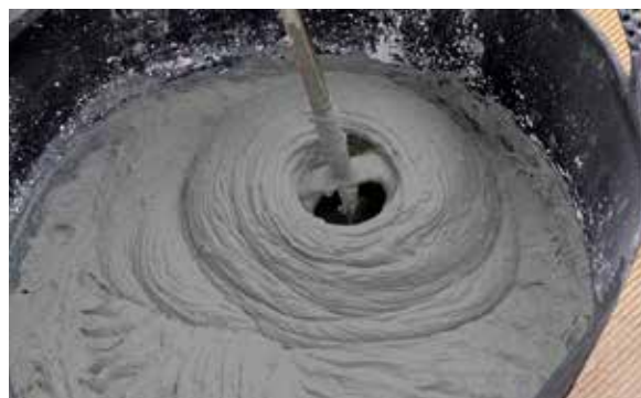
2. Amassadura do CX-28 Isolxtrem Poliestirex
