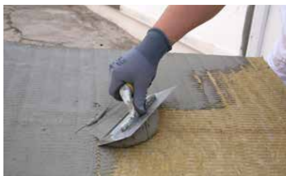
7. Colocação da placa de lâ de rocha
