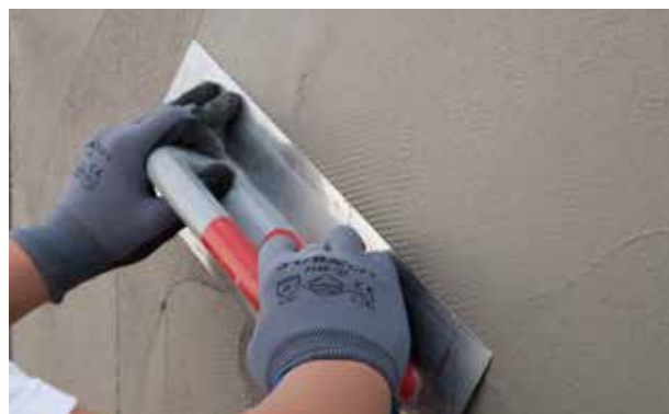
12. Rebocos na malha de reforço
