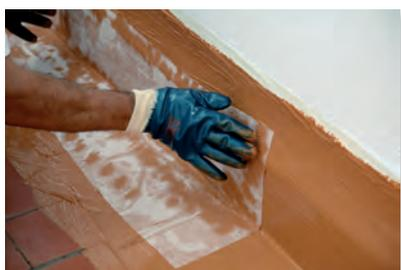
Sur cette première couche fraîche, nous poserons la bande de fibre de verre coupée sur mesure, en nous assurant de bien poser et aplanir la surface sans laisser aucune bulle d'air.
