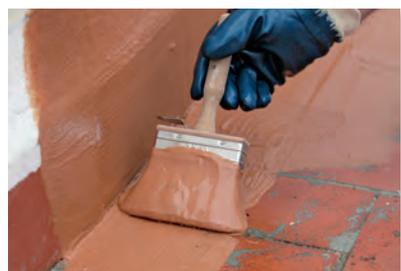
Le talus que nous allons former se réalisera en appliquant une généreuse quantité d'imperméabilisant sur les parties verticales et horizontales de l'acrotère.
