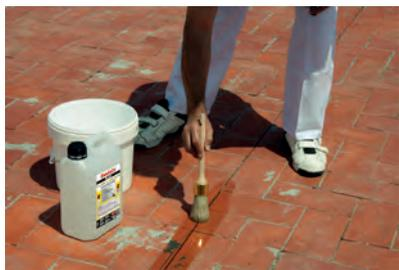
Une fois les travaux de conditionnements des jointures de dilatation conclus, on aspirera toute la poussière résultante et on consolidera la fissure en appliquant à l'intérieur notre fixateur/durcisseur **rx-501 fijapren au dissolvant**. Par la suite nous traiterons les jointures avec notre **rx-400 rualaix elastic** ou avec notre mastic pour joints de dilatation **b-32c**.
