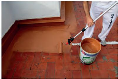
Une fois conclues la préparations des points singuliers de la terrasse, nous procéderons à l'imperméabilisation de celle-ci en suivant le même procédé utilisé pour l'acrotère, en appliquant l'imperméabilisant sur une superficie égale ou légèrement supérieure à la voile de fibre de verre que nous avons préalablement coupé sur mesure de la terrasse que nous désirons imperméabiliser.
