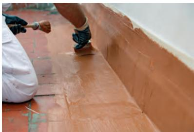
Une fois la bande de FDV posée, nous appliquerons une seconde couche du produit imperméabilisant en procurant de recouvrir totalement la voile et en appuyant fermement avec la broche.
