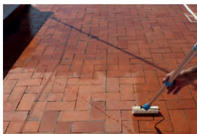
Les surfaces qui requièrent des travaux de réhabilitation intenses générant une grande quantité de poussière doivent être nettoyées et consolidées en y appliquant une dernière main du fixateur/durcisseur **RX-501 FIJAPREN AU DISSOLVANT**.
