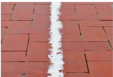
Une fois restaurées, il convient de procéder au pontage des jointures de dilatation à l'aide d'une bande de fibre de verre de plus ou moins 15 centimètres de large que l'on posera tout au long de la jointure et que l'on recouvrira avec l'un des imperméabilisants pour terrasses de la gamme wash-imper, elastine, acrilastic o acridur.
