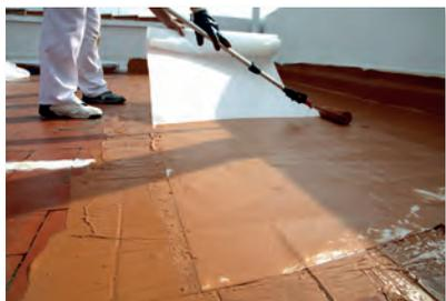
On appliquera par la suite, et avant que ne sèche la première couche, une seconde main du produit imperméabilisant sur la voile de fibre de verre en nous assurant de la recouvrir dans sa totalité.
