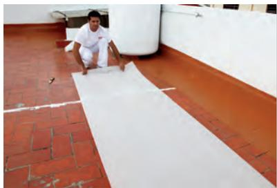
Afin d'optimiser le temps d'application de l'imperméabilisant, il est recommandé de préparer le matériel que nous utiliserons. Il est particulièrement important de couper la voile de fibre de verre sur mesure de la terrasse à imperméabiliser.
