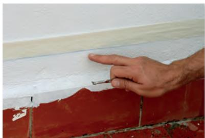
Afin d'assurer l'hermétisme et une étanchéité totale de la terrasse, nous commencerons par traiter l'acrotère avant d'imperméabiliser la surface horizontale.
