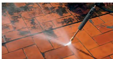
Après séchage de la solution anti-mousse, nous procéderons au nettoyage de la surface à l'aide de la laveuse à pression. Si nous ne disposons pas d'une machine à jet d'eau, on devra utiliser une brosse à poils en acier afin de gratter les résidus tout en lavant la surface abondamment avec de l'eau.
