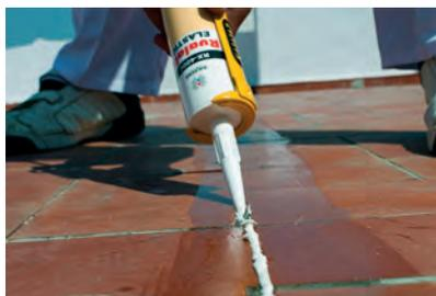
Lorsque nos travaux se font sur un chantier neuf avec les joints de dilatation déjà existantes mais vides, on remplira les jointures avec notre **RX-400 RUALAIX ELASTIC** ou avec notre mastic pour joints de dilatation **b-32c**.
