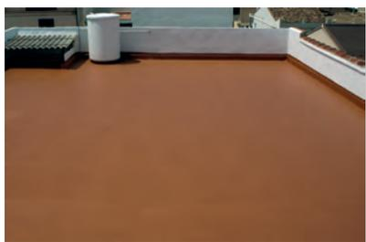
Nous continuerons l'application de l'imperméabilisation en suivant le procédé décrit antérieurement, sans oublier que les bandes de fibre de verre se superposent l'une sur l'autre.
