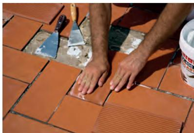
Contrôler la dureté et la consistance du sol par sondage avec un marteau afin de s'assurer de la bonne adhérence du revêtement de finition existant. Il est nécessaire de recoller tous les éléments dégradés ou même les remplacer si nécessaire.
