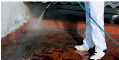
Si le support à imperméabiliser est contaminé ou contient d'autres types d'impuretés tels que de la poussière, du lichen ou autres micro-organismes, il doit être nettoyé et désinfecté.
