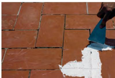
Une fois le fixateur ayant séché, on remplira les joints et les fissures avec notre enduit **RX-406 FIBROLASTIC** à l'aide d'une spatule qui permet de l'introduire et de répartir correctement le produit à l'intérieur des cavités.
