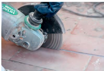
Dans le cas d'un chantier de réhabilitation où l'on constate l'absence de joints de dilatation, nous devons créer ces-dernières, en prenant toujours soin de faire les fissures selon les dimensions qu'établissent les normes en vigueur.
