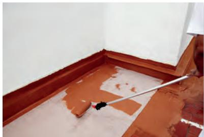
Une fois la bande de fibre de verre posée, on exercera sur celle-ci une pression adéquate avec le rouleau afin d'éliminer toutes les bulles d'air attrapées entre les diverses couches.
