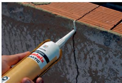
Rénover en cas de besoin les angles entre les parois verticales et la surface horizontale. Assainir les fissures supérieures à 2 mm en les ouvrant 2 fois plus que leur taille originale et en appliquant à l'intérieur notre fixateur/durcisseur **RX-501 FIJAPREN AU DISSOLVANT**. Laisser sécher au moins 4 heures et appliquer par la suite notre mastic **RX-400 RUALAIX ELASTIC** ou notre enduit pour joints de dilatation **B-32C**.
