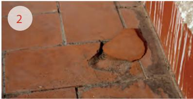
L'absorption des matériaux et la nulle déformabilité des joints de mortier entre les pièces provoquent une lente dégradation de la terrasse. L'apparition de lichens, mousse et autres micro-organismes contribue également à la détérioration.
