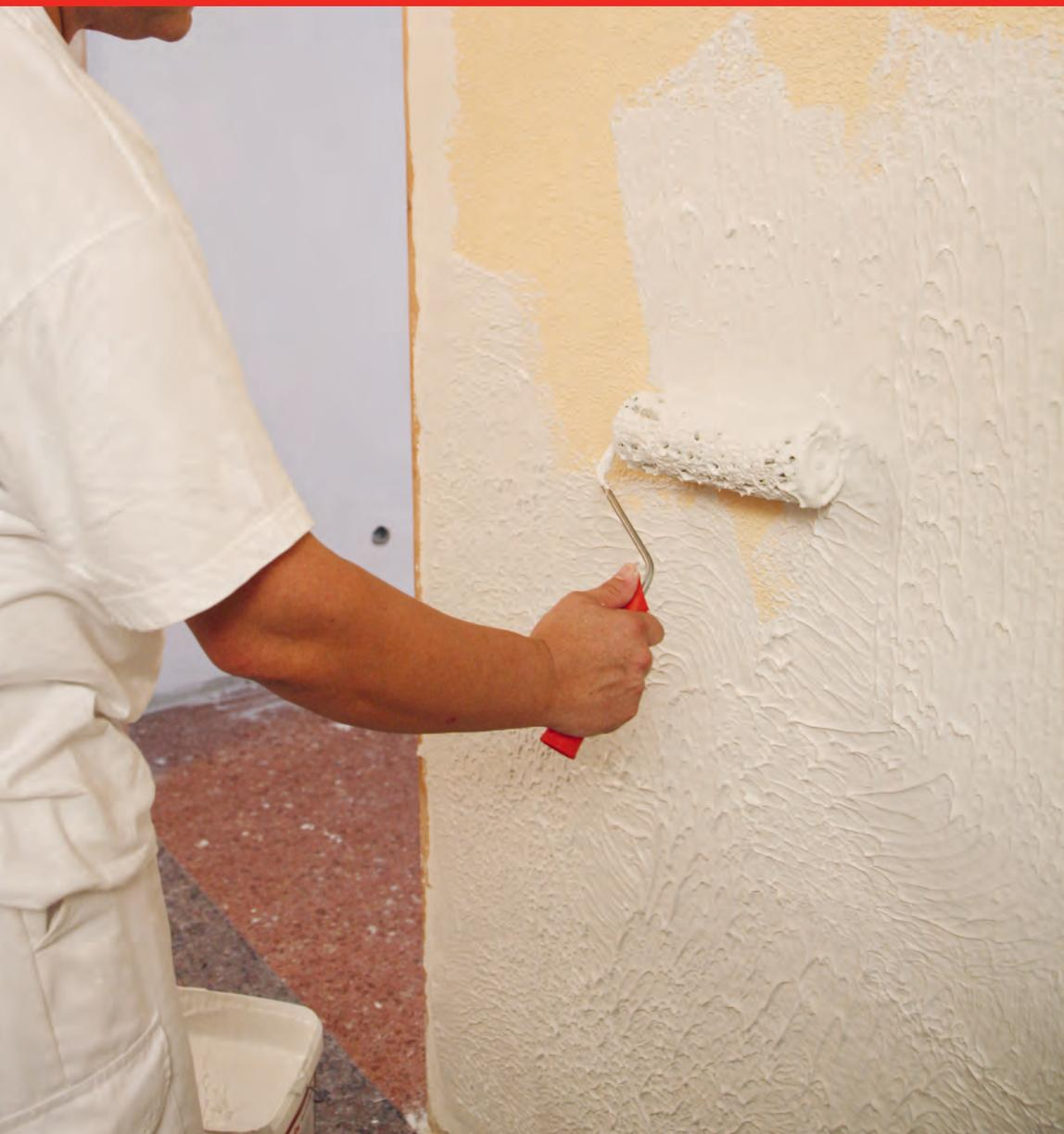
Si consiglia di depositare il materiale necessario in superfici non superiori a 2m<sup>2</sup>, per evitare che possa asciugare in alcune aree e ostacolare l'operazione di lisciatura.
