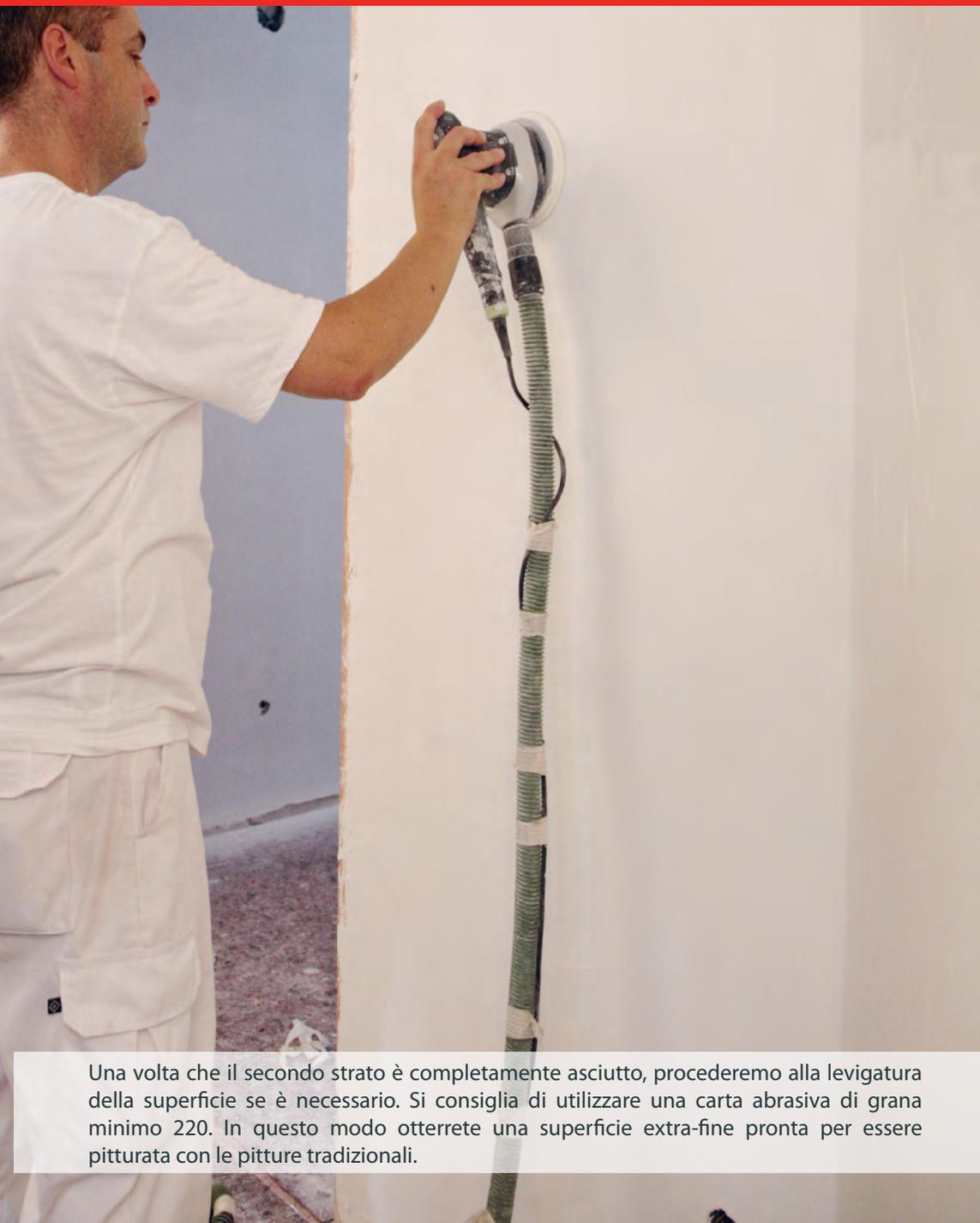
Una volta che il secondo strato è completamente asciutto, procederemo alla levigatura della superficie se è necessario. Si consiglia di utilizzare una carta abrasiva di grana minimo 220. In questo modo otterrete una superficie extra-fine pronta per essere pitturata con le pitture tradizionali.
