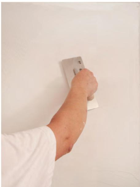
L'operazione di lisciatura si realizza sempre nello stesso modo: il secondo strato si applica nella stessa forma del primo.
