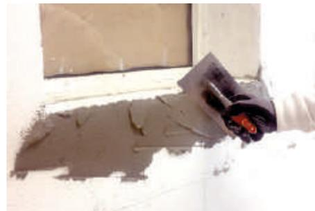
Seguidamente instalaremos el perfil alfeizar con malla sobre el mortero, ejerciendo una presión moderada.
