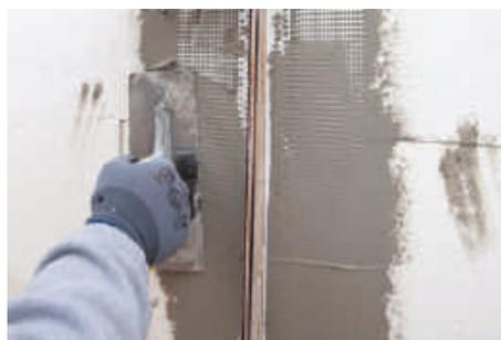
Una vez seco **CX-28 Isolxtrem Poliestirex**, retiraremos del interior del perfil junta de dilatación las tiras de EPS o listón de madera y una vez terminado el sistema, colocaremos el embellecedor.
