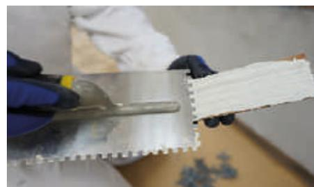
Una vez depositado el adhesivo sobre la pieza cerámica, se deberá presionar sobre el soporte. Desplazar la baldosa en dirección perpendicular a los surcos del peinado del cemento cola y en sentido contrario a la baldosa adyacente, para repartir homogéneamente el cemento cola en el intradós de la pieza y soporte.
