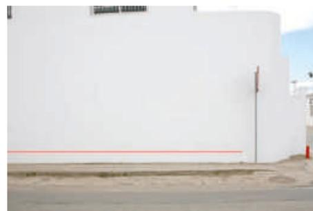
A partir de ahí, con la ayuda de un nivel láser y de un tiralíneas, marcaremos una línea en todo el perímetro a actuar.
