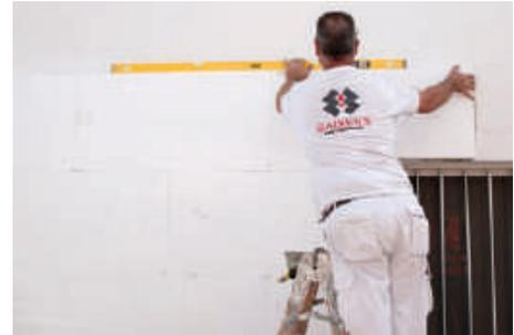
No se debe hacer coincidir la junta formada por dos perfiles de arranque, con la junta de los paneles de EPS. Deben tener una distancia de separación mínima de 10 cm.
