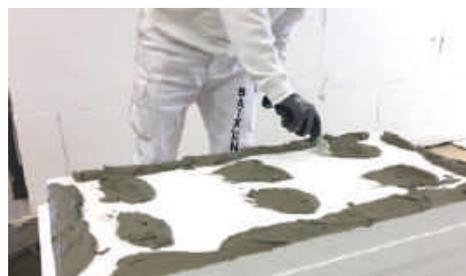
Una vez depositado el material sobre el panel, lo colocaremos inmediatamente sobre el soporte, la primera hilera partirá desde el perfil de arranque.
