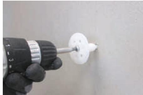
Se deberá realizar una retícula sobre el mortero, de forma manual o con ayuda de un nivel laser, de tal forma que la cantidad a instalar sea 2 Uds/m<sup>2</sup>. La primera fijación se situará en la esquina a 13 cm del borde inferior (Perfil de arranque) y a (38 cm + Espesor de placa) del borde lateral (Esquina). Las siguientes fijaciones se instalarán según el gráfico.
