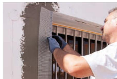
Embeberemos la malla de fibra de vidrio con la llana en el mortero, para sujetar el perfil al soporte.
