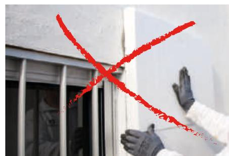
Para evitar que se produzcan puentes térmicos en huecos de fachada, se deberán instalar paneles de EPS en dinteles y jambas de ventanas y puertas.
