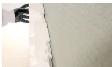
El encolado de los paneles de EPS de espesor  $> 40$  mm, se realizará mediante la aplicación de un cordón perimetral, dejando las esquinas libres de mortero para poder rectificar su colocación, y 6 pelladas en la zona central del tamaño de un puño. De manera que al presionar la placa sobre el soporte, el mortero alcance una superficie mínima del 80% del panel.
