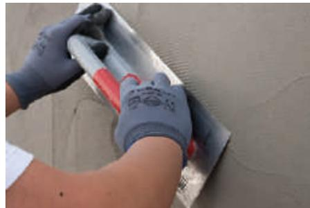
Una vez más, esta operación de enlucido de acabado se realiza aplicando **CX-28 Isolxtrem Poliestirex** con la ayuda de una llana. La aplicación se realiza siempre verticalmente de abajo hacia arriba, poniendo material y quitando el sobrante. Los empalmes se realizan al contrario, de arriba hacia abajo.
