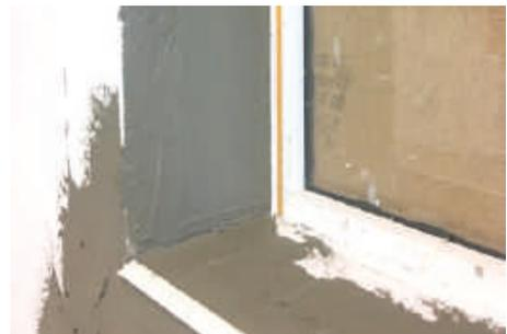
Posee una pestaña que contiene una lámina autoadhesiva para ubicar un plástico o papel y así proteger la carpintería de la instalación de la nueva envolvente. Posteriormente se puede retirar la pestaña para que quede el perfil enrasado con el acabado.
