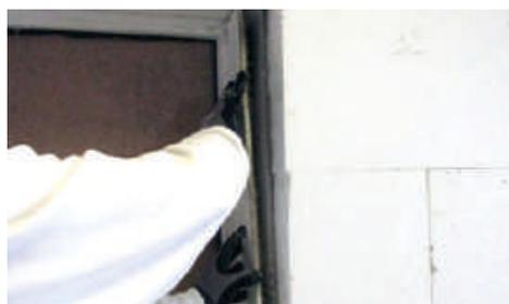
Los paneles que estén dañados, rotos o excesivamente deformados, no se deben instalar. Según su estado, se podrán utilizar para zonas donde es necesario recortar la pieza.
