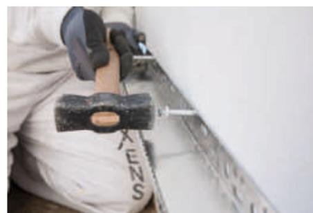
Los distanciadores se situarán detrás del perfil de arranque, para absorber las posibles irregularidades de planeidad en la superficie del soporte. Se deben instalar tantos como sean necesarios, variando el número o espesor de estos en cada punto, para evitar deformaciones en la fijación del perfil de arranque.
