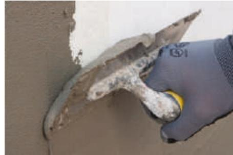
Seguidamente, se presentará la malla **RG-330 Malla de fibra de vidrio Isolxtrem** sobre la superficie y ejerciendo presión mediante una llana, la embeberemos sobre la superficie de mortero aplicada. No se retirará el material sobrante, se redistribuirá sobre toda la superficie de la malla para recubrirla completamente.
