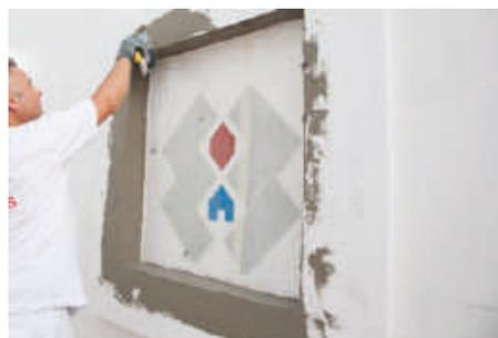
Seguidamente instalaremos el perfil goterón con malla sobre el mortero, ejerciendo una presión moderada.
