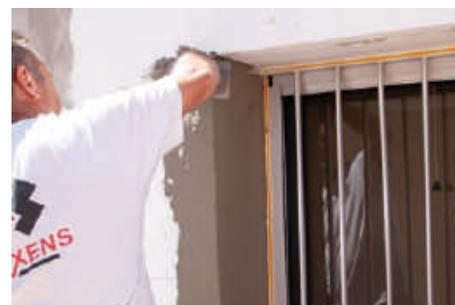
Seguidamente instalaremos el perfil cantonera con malla sobre el mortero, ejerciendo una presión moderada.
