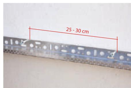
El primer tornillo se debe situar a una distancia inferior de los 5 cm del extremo del perfil.
