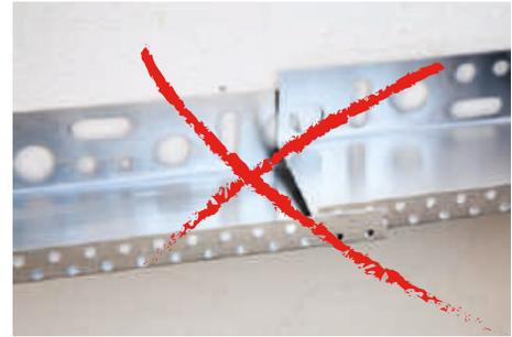
En esquinas, se aconseja la instalación de piezas especiales para estos encuentros, tanto en ángulos interiores como en los exteriores o realizar cortes a inglete de los perfiles de arranque.
