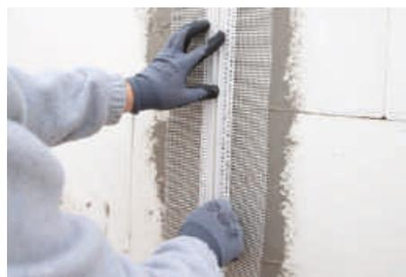
Para evitar que durante la instalación se nos mueva el perfil o lo ensuciamos con material de agarre, colocaremos tiras de EPS o un listón de madera.
