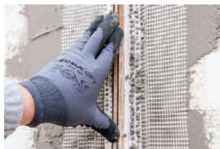
Embeberemos la malla de fibra de vidrio con la llana en el mortero, para sujetar el perfil al soporte, y dejaremos secar.
