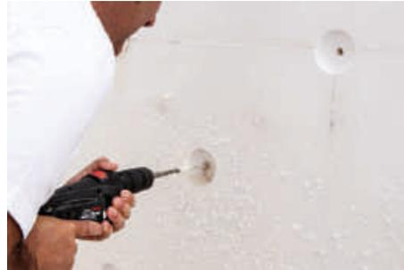
A continuación, situaremos la espiga hasta que quede enrasada con la zona rebajada y golpearemos el perno con un martillo hasta que se introduzca por completo. Acto seguido, colocaremos el tapón de EPS con la ayuda de una llana y ejerciendo una ligera presión, terminaremos de instalar la tapa para dejarla al mismo nivel que la placa de EPS.
