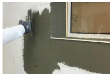
Seguidamente instalaremos la malla refuerzo sobre el mortero, ejerciendo una presión moderada.
