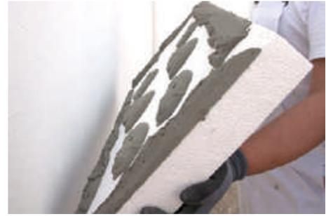
A continuación, presionaremos los paneles de EPS mediante una llana, para asegurarse que tenga una buena adherencia sobre el soporte. El golpeo con la mano no es recomendable, ya que se podrían deformar.
