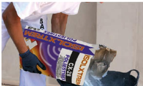
1. Adición del CX-28 Isolxtrem Poliestirex al agua
