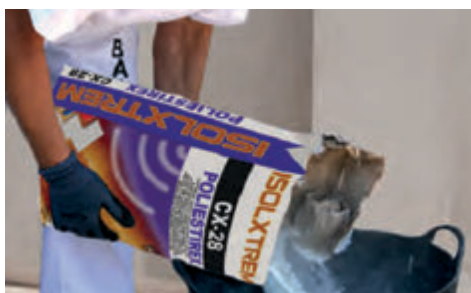
1. Adición del CX-28 Isolxtrem Poliesticirex al agua
