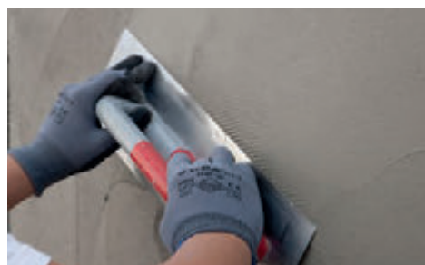
12. Enlucido sobre la malla de refuerzo
