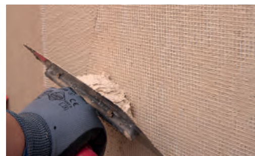
8. Cubrir la malla con PX-20 / PX-28
