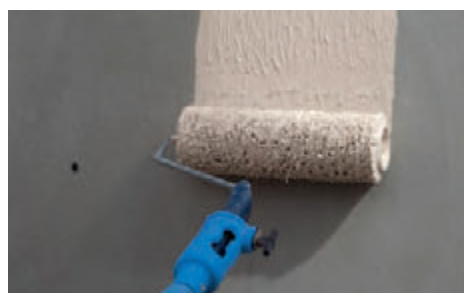
Aplicación sobre CX-28 Isolxtrem Poliestirex
