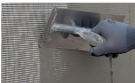
11. Colocación de la malla de refuerzo
