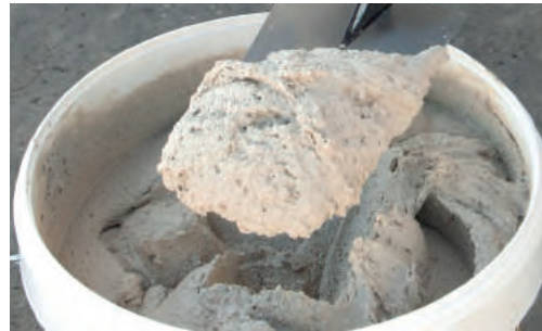
2. Extraer el PX-20 / PX-28 con la ayuda de una paleta
