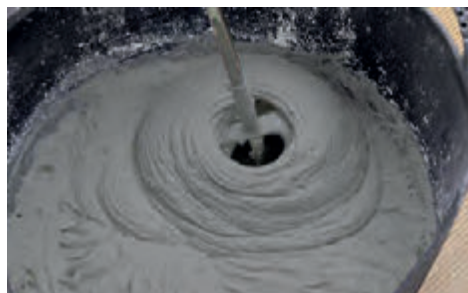
2. Amasado del CX-28 Isolxtrem Poliesticirex
