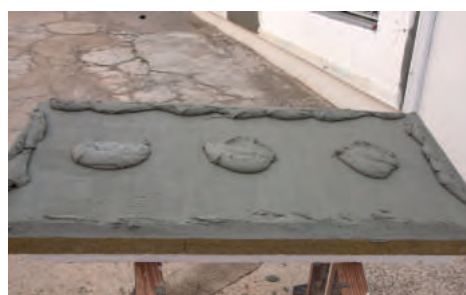
8. Encolado de placa de lana de roca
