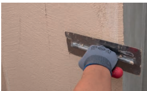
9. Alisar el PX-20 / PX-28 depositado sobre la malla
