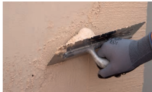
4. Aplicar PX-20 / PX-28 sobre el soporte
