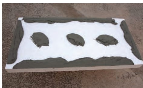
5. Encolado de placa de EPS
