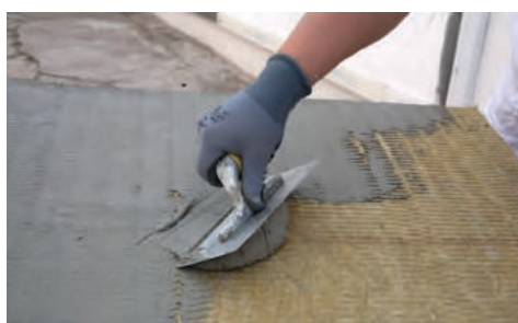
7. Enlucido de placa de lana de roca
