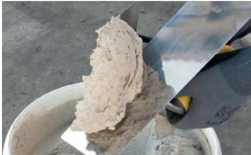
3. Colocar PX-20 / PX-28 en la llana
