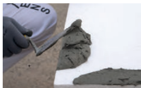
4. Aplicación del CX-28 Isolxtrem Poliesticirex sobre EPS
