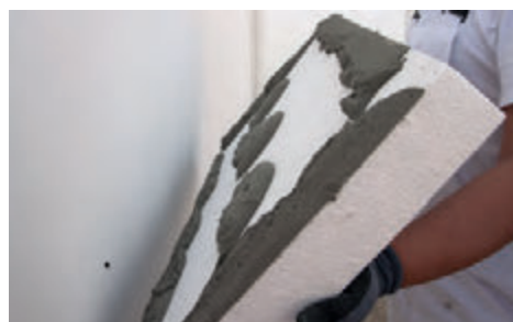
6. Colocación de la placa sobre el soporte
